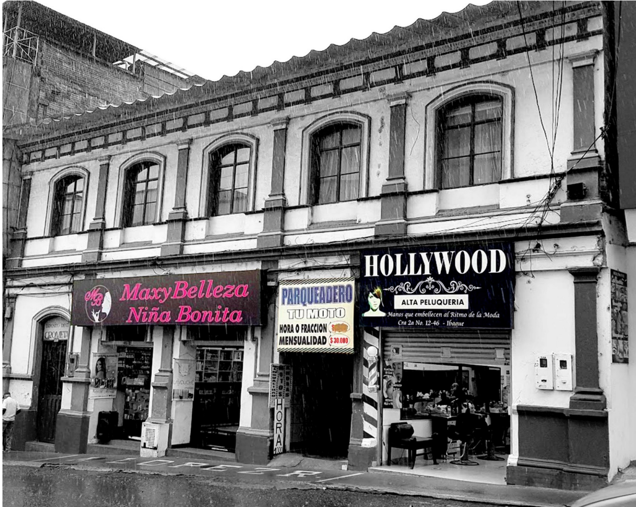
Figura 16. Detalles gráficos en la fachada del edificio López R. en la actualidad.
