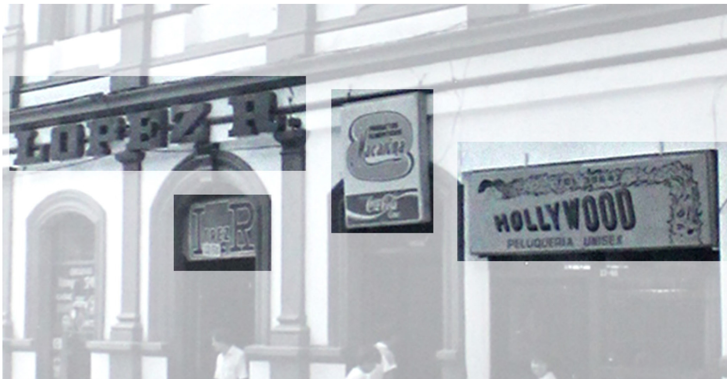
Figura 15. Detalles de avisos sobre la fachada.
