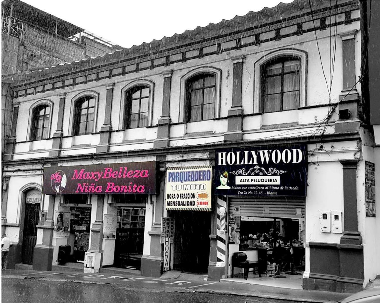
Figura 16. Detalles gráficos en la fachada del edificio López R. en la actualidad.
