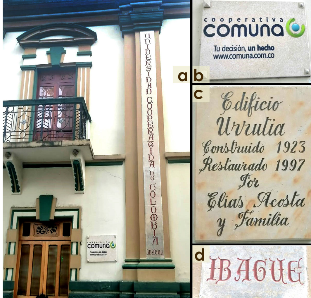
Figura 8. Detalles publicitarios en la fachada del edificio Urrutia (2021).
