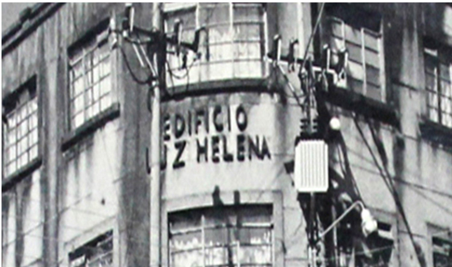
Figura 30. Detalle del aviso del edificio Luz Helena.
