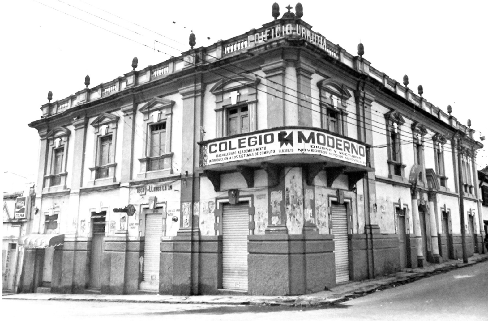
Figura 7. Edificio Urrutia en 1992. Fotografía de David Oviedo (1992).
